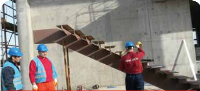
Merdiven İmalatı Staircase Manufacturing
