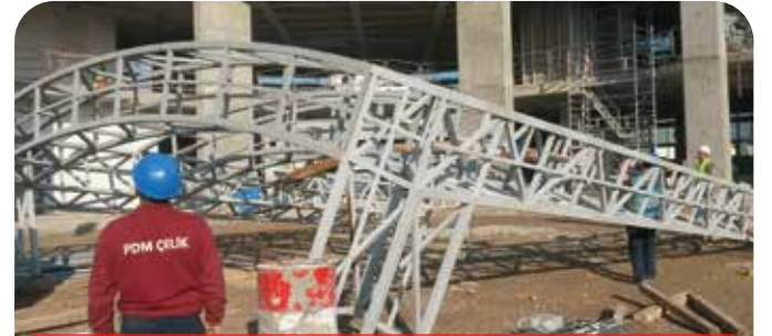
Bina Dış Cepe Kanopi İmalatı External Building Facade Canopy
