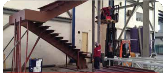
Merdiven ve Sahanlık İmalatı Stair & Platform Manufacturing
