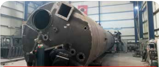
Tank İmalatı Tank Manufacturing
