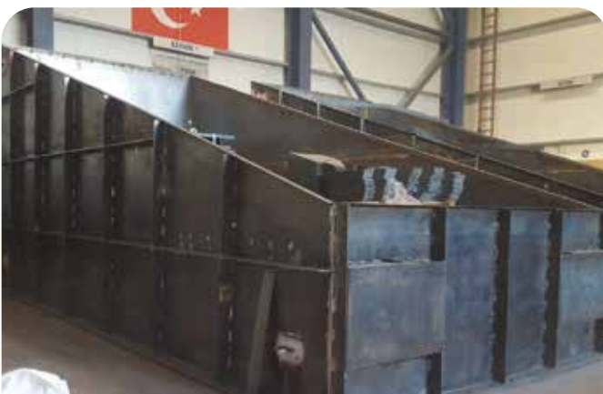
Aritma Kanal İmalatı Wastewater Channel Manufacturing
