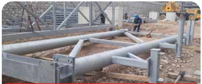
Köprü İmalatı Bridge Manufacturing
